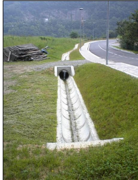
**Foto n.19 e 20 – Viste sull'imbocco del tratto intubato della Valle della Sortita (0058) e sul canale a cielo aperto sottostante (0059).**
