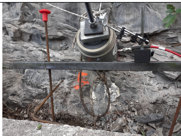
Figura 5 –Prova di carico. Ancoraggio n°5
