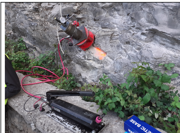
Figura 4 –Prova di carico. Ancoraggio n°4
