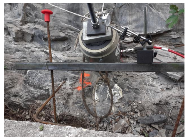
Prova di carico. Ancoraggio n°5
