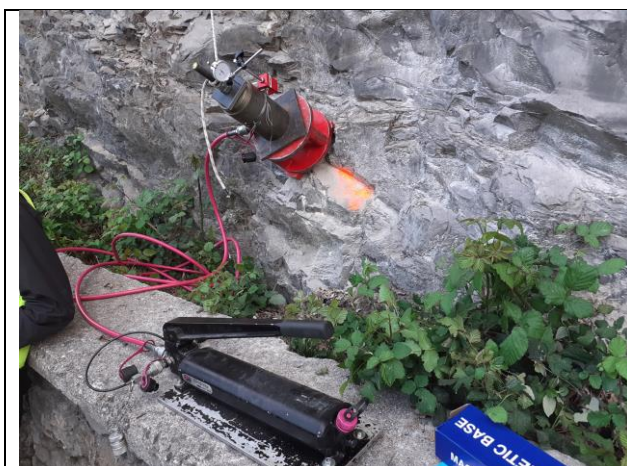
Prova di carico. Ancoraggio n°4
