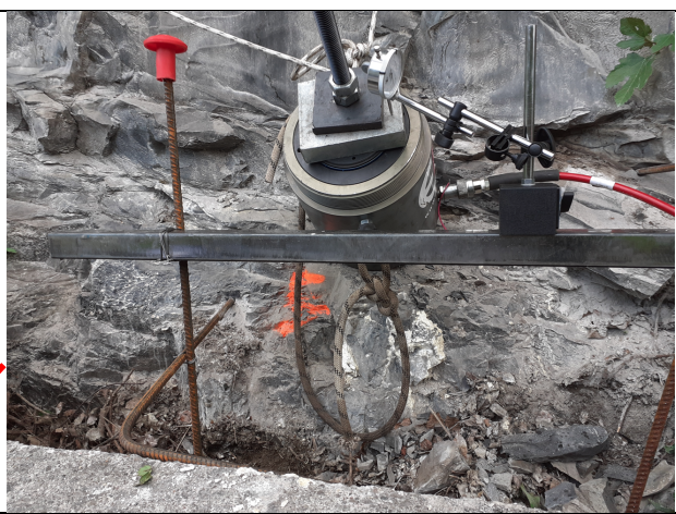
Figura 3 –Prova di carico. Ancoraggio n°5
