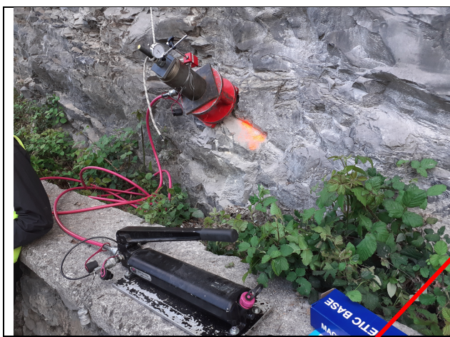
Figura 2 –Prova di carico. Ancoraggio n°4
